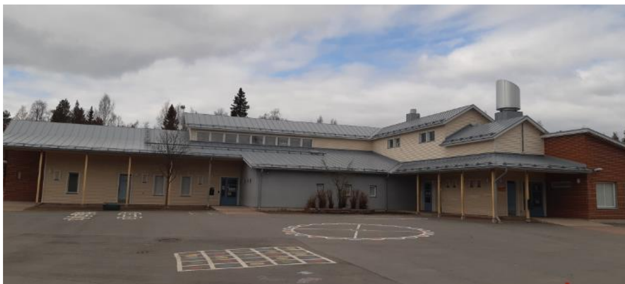
Kuva 11. V. 2006 (C) valmistunut yksikerroksinen koulurakennus.
